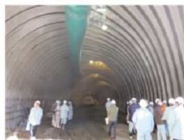
<国道411号トンネル工事>
